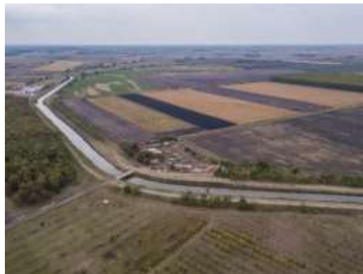
Szeghalmi-főcsatorna kotrás után
