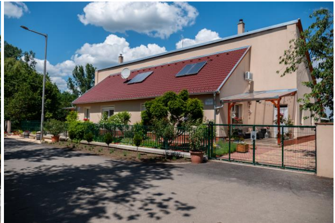
A felújított szolgálati lakások.
