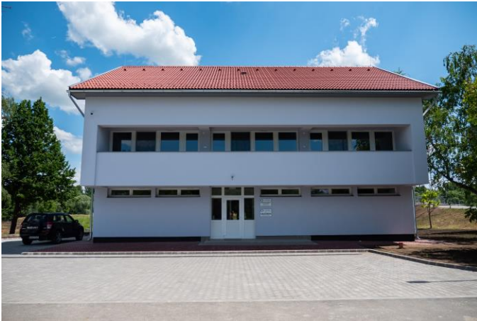
Az elkészült üzemviteli épület.
