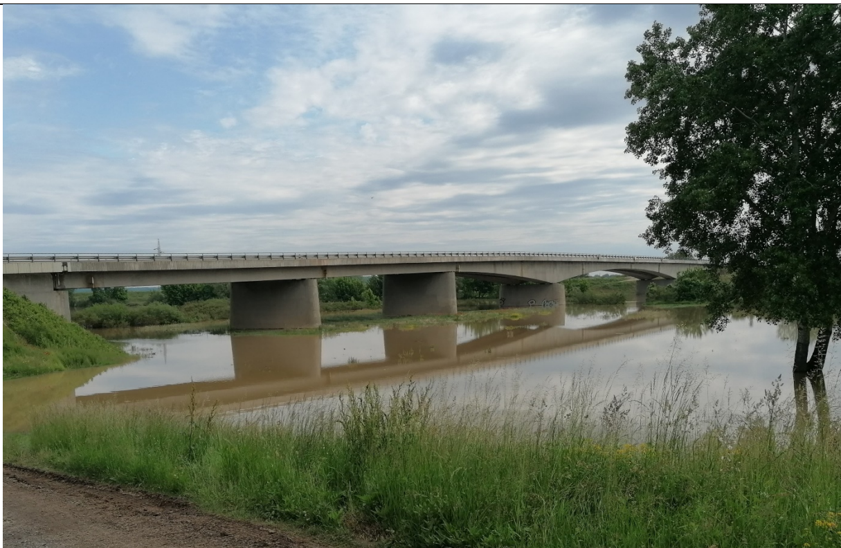
Kettős-Körös I. fokú árvízvédelmi készütség – Dobozi híd
