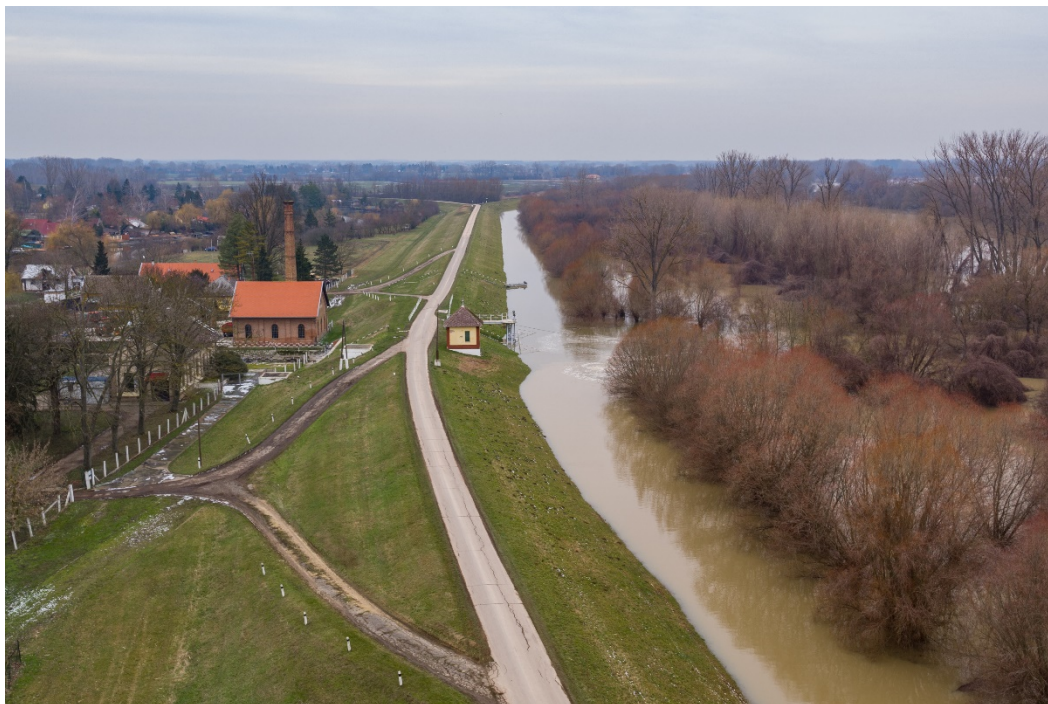
Békésszentandrás szivattyútelep, mely a Szarvas-Békésszentandrás-holtágban összegyülekező belvizeket emeli a Hármaskörösbe
