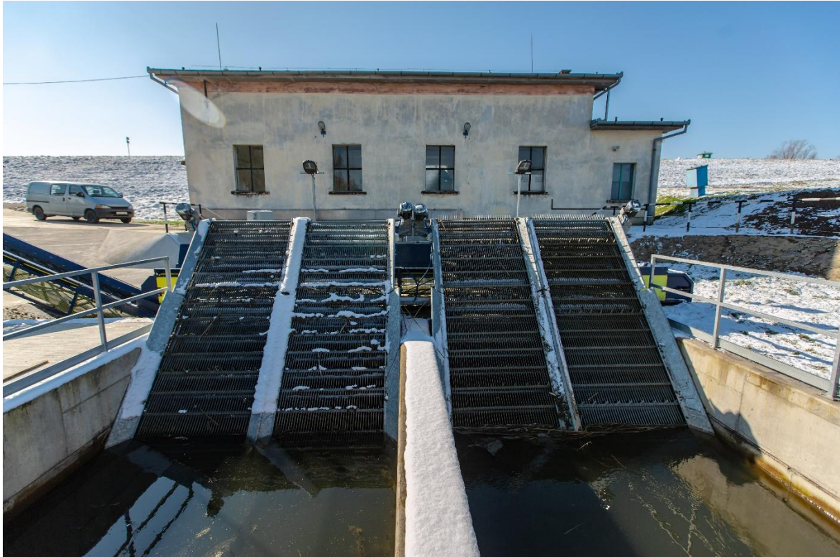
Vargahosszai szivattyútelep gépi gereb
