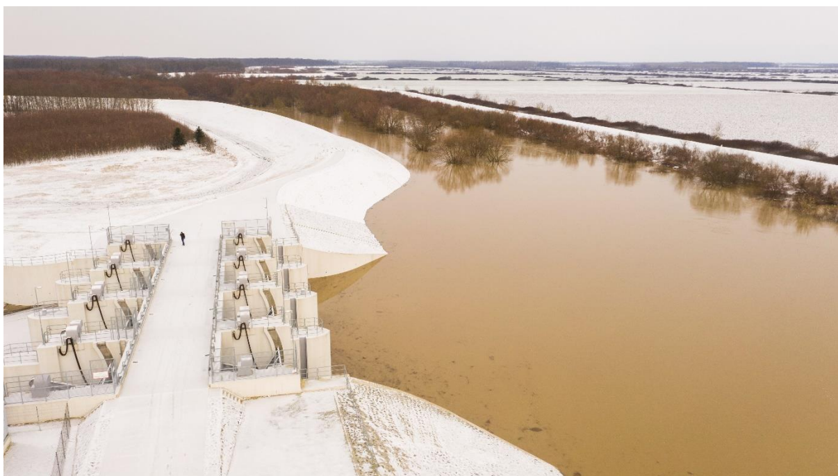
Mályvádi árvízi szükségtározó felső megnyitási hely, Fekete-Körös – árhullám
