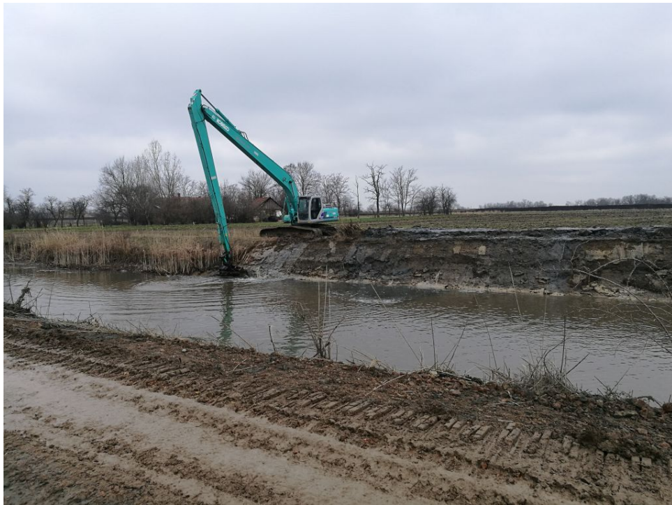
Vízfolyás-gátló akadály eltávolítása a Dögös-Kákafoki-főcsatornán
