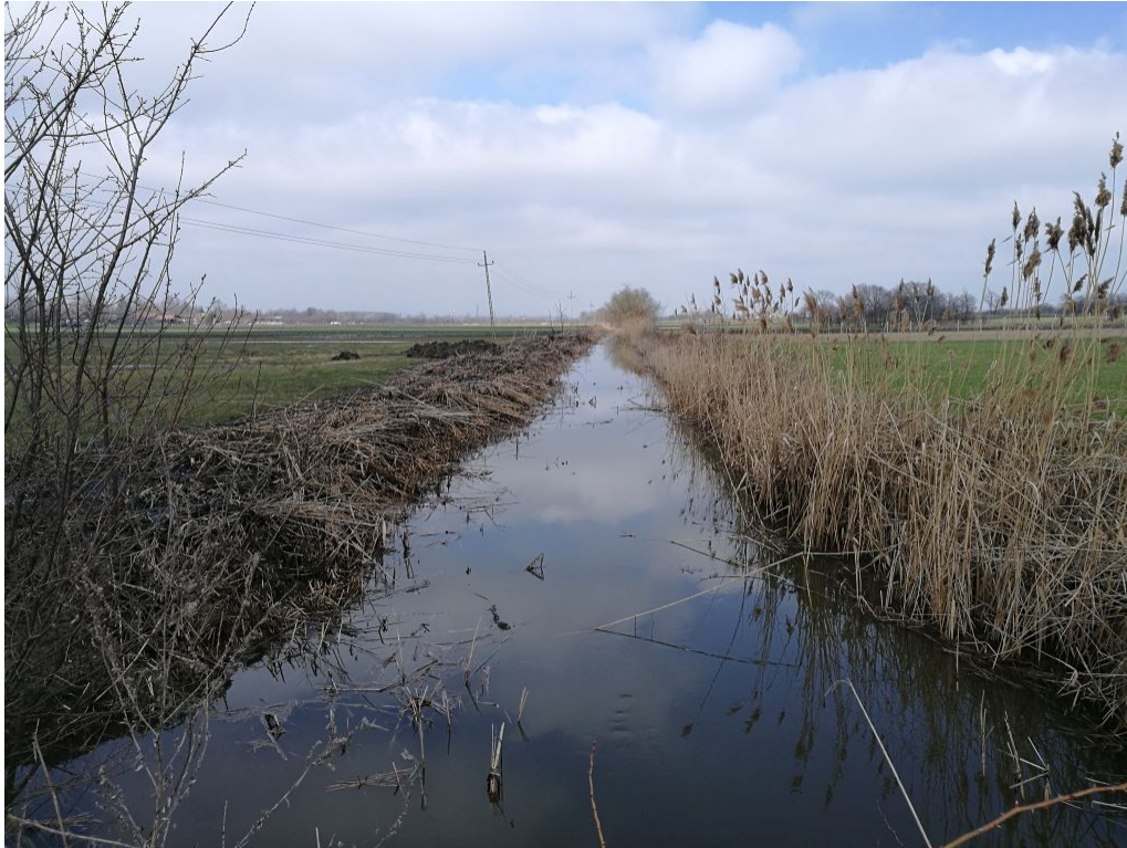
Vízfolyás-gátló akadály eltávolítása a Cigányér-alsó-csatornán
