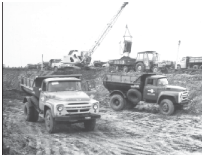
Fekete-Körösi átvágás helyreállítási munkái
