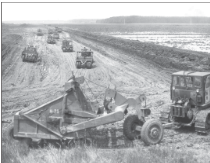
Dénsmajor település megvédése töltésépítéssel
