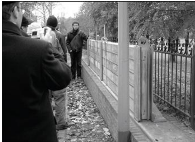
Mobil árvízvédelmi fal a Maas mentén Borgharennél
