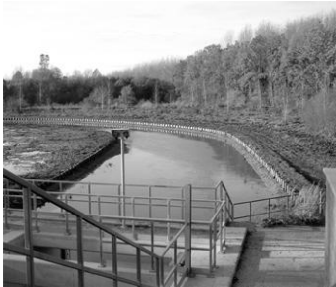
A tározótér látképe az árvízhozamot szabályzó műtárgyról
