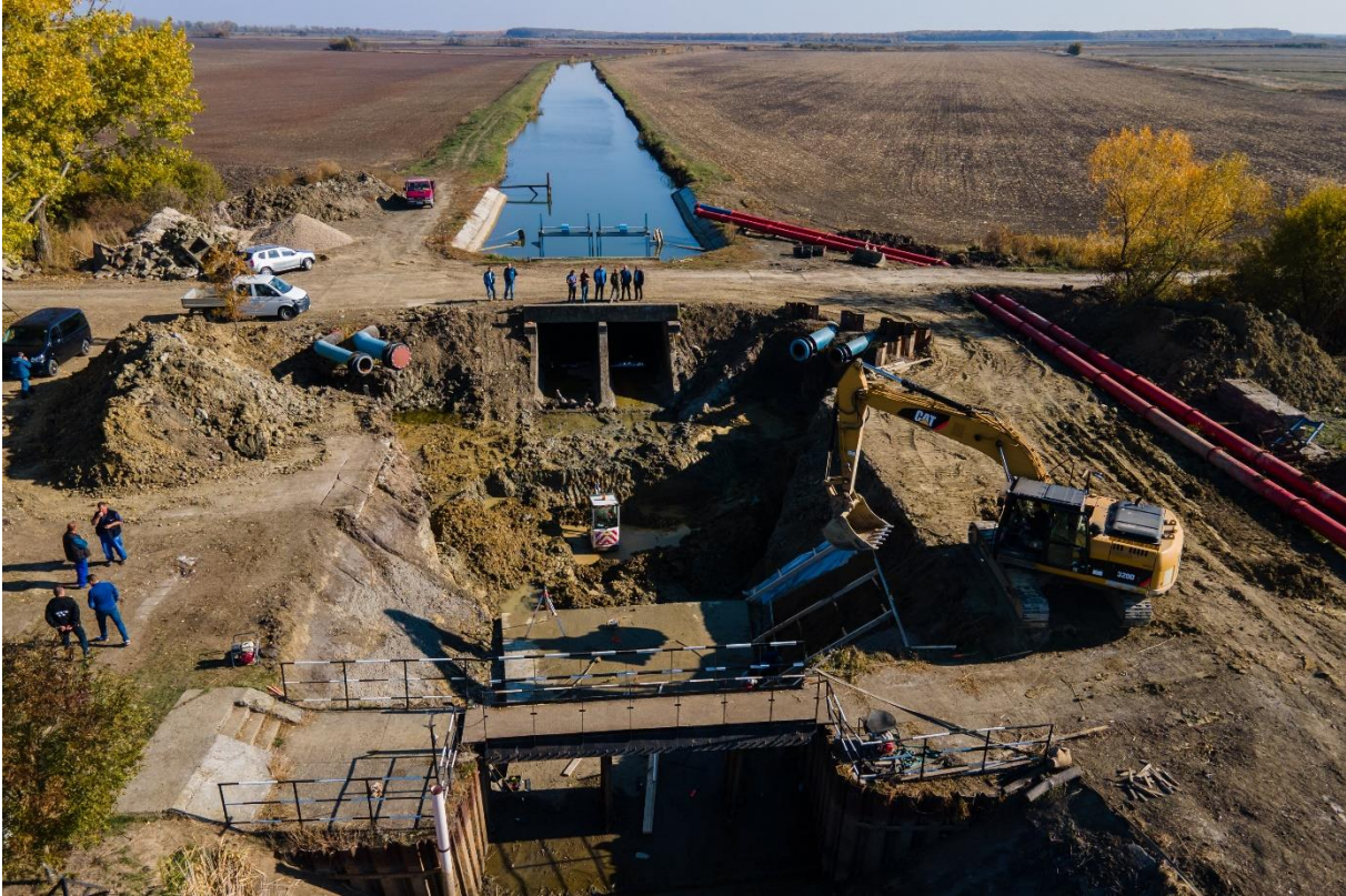
A Dögös-Kákafoki I. átemelő szivattyútelep elektrifikálásának II. üteme
